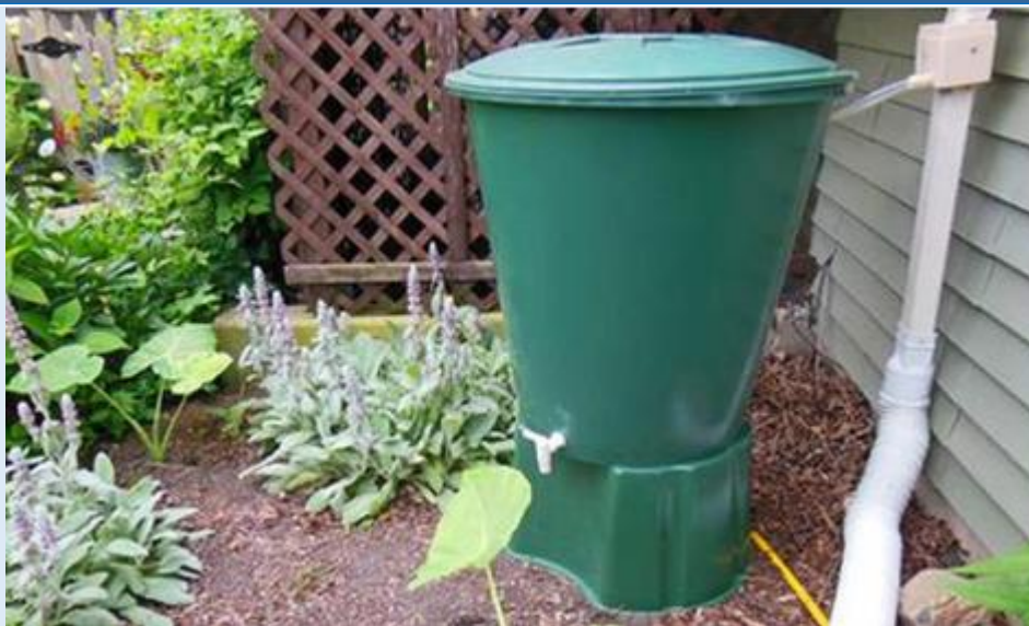
Esempio di serbatoio di piccole dimensioni, alimentato direttamente dai pluviali
