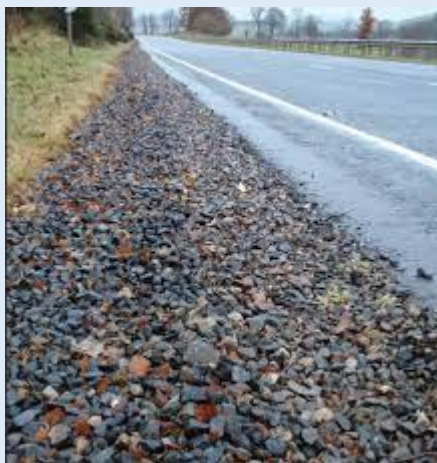
Esempio di dreni filtranti Progetto LIFE Derris
